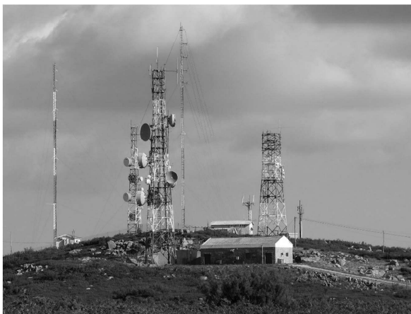
Figura 1 - Estação Rádio Base
